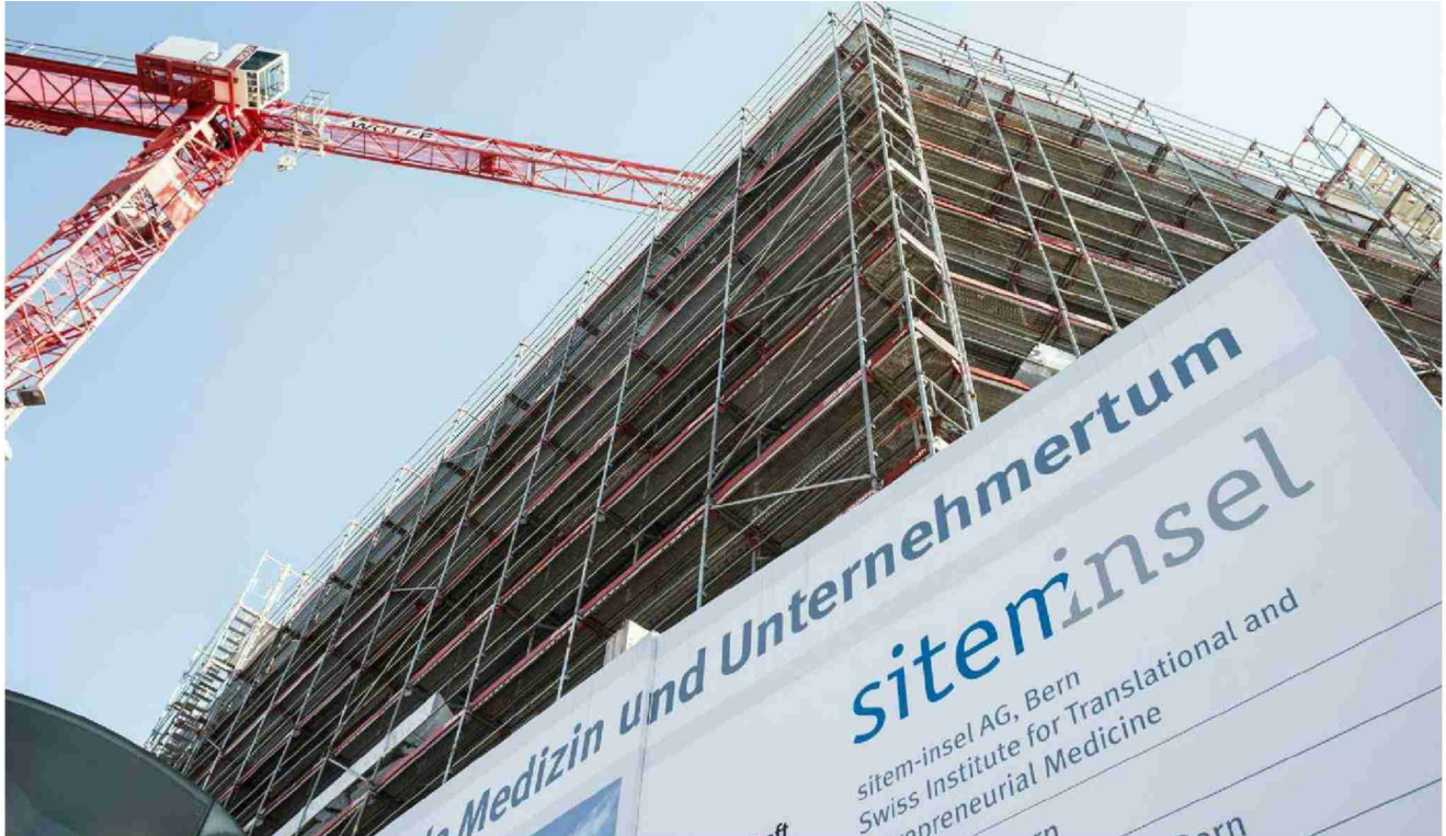
Auf dem Areal des Inselspitals wächst das Forschungszentrum Sitem-Insel in die Höhe. Foto: Franziska Rothenbühler
